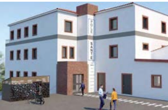
Avec le concours de la mairie de Savigneux, les Mutuelles de France Loire ont investi et construit un pôle de santé destiné à accueillir de nombreux professionnels de santé.
